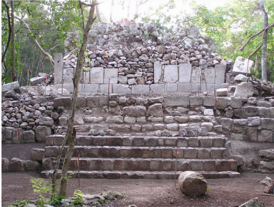
Figura 4-53. Vista general del lado frontal de la Estructura N1050E1065 al finalizar la temporada.
