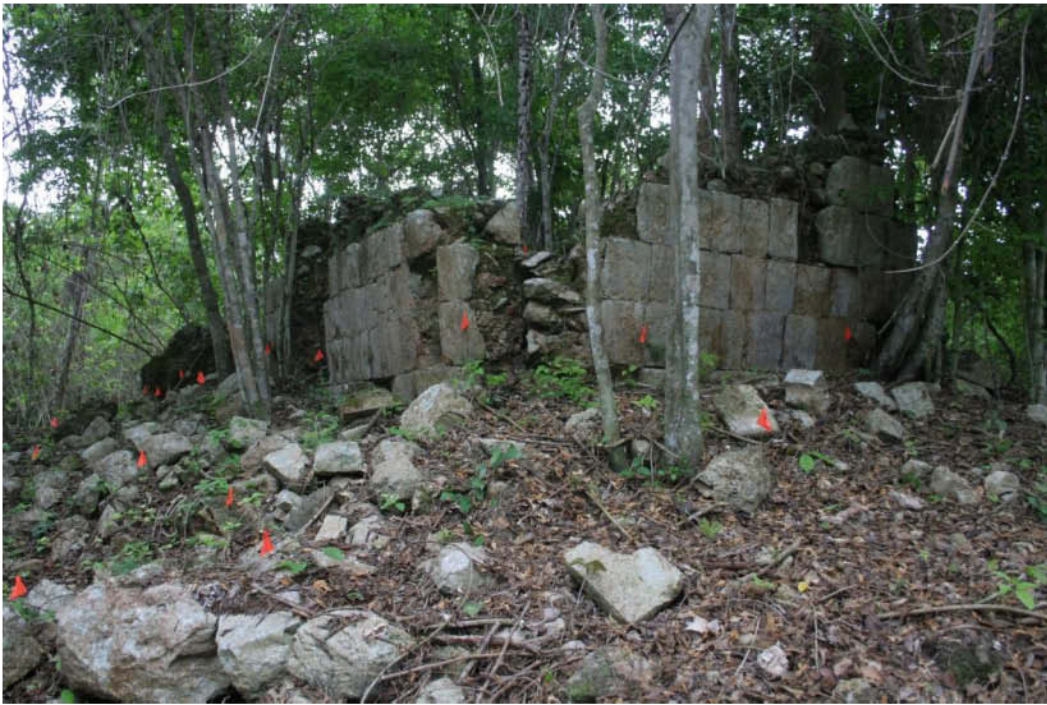
Figura 2-14. La Estr. N5125E4875 vista desde el suroeste (lados oeste y sur) (IMG_3635)
