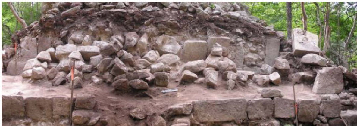
Figura 4-36. Estructura N1050E1065. Vista general del lado frontal (oeste) del edificio superior en proceso de excavación.
