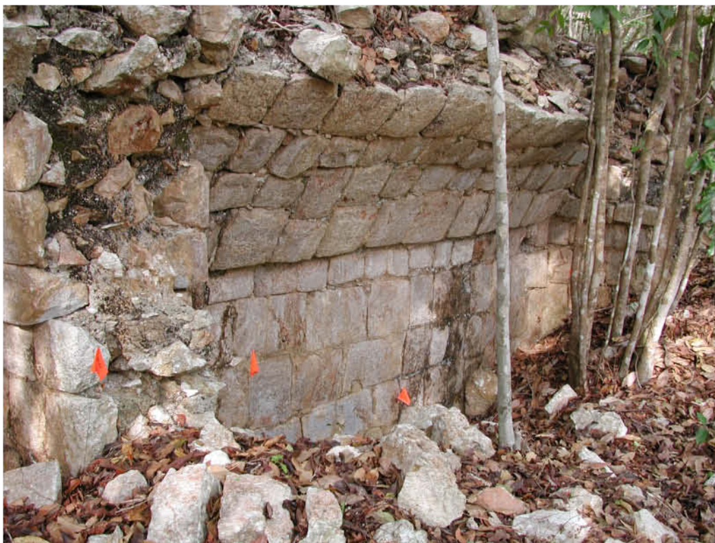
Figura 2-13. Restos de la bóveda, Cuarto 2 de la Estr. N4650E5175..
