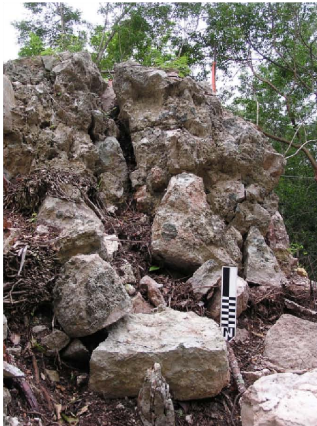
Figura 4-4. Estructura N1050E1065. Fragmento de bóveda colapsada al interior del templo; nótese la forma de las piedras de la bóveda.
