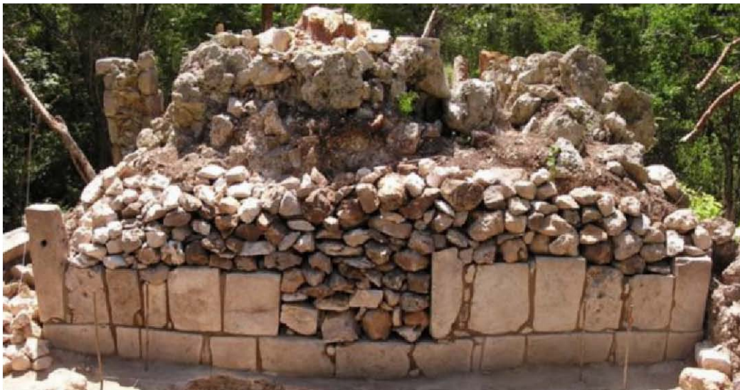
Figura 4-54. Vista general del edificio superior de la Estructura N1050E1065 después de los trabajos.
