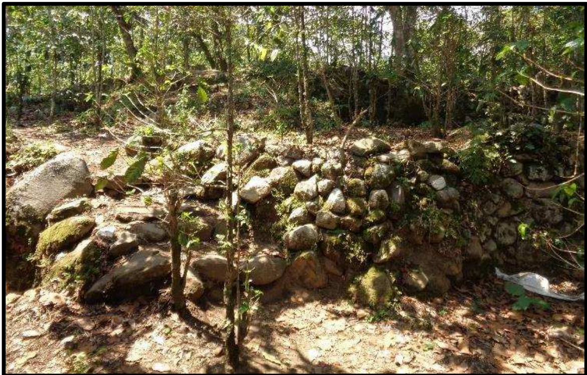
Figura 9.1. Muro de contención y gradas de acceso al área residencial de San Juan Antiguo (FS 18). Foto Gavin Davies.
