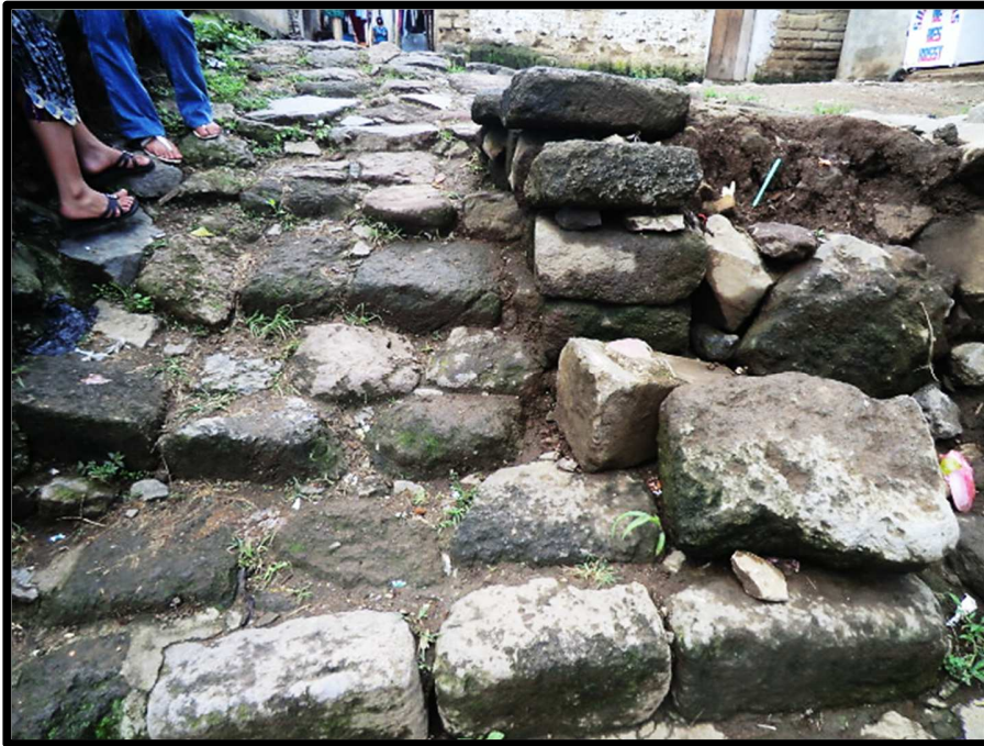
Figura 6.2. Sección de gradas (ahora destruidas) incorporando bloques que probablemente vinieron de estructuras prehispánicas cerca del centro del pueblo. Foto por autor, 2011. Fotografía Gavin Davies.
