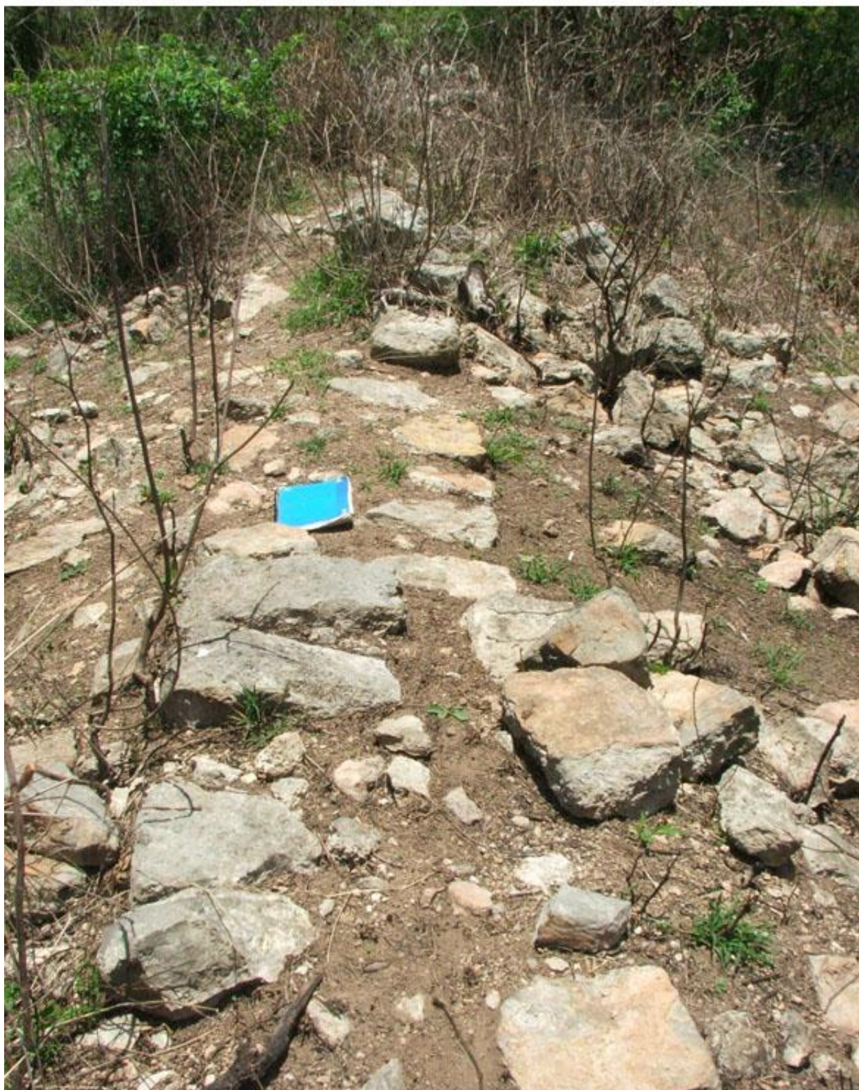
Figura 3.18: Muro de la superestructura de E1N1-9
