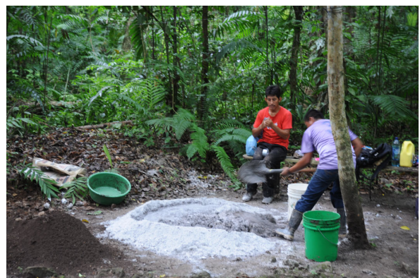
Figura 14.2. Preparación de mezcla a base de cal y agua, que en conjunto con las piedras se utilizó para construir las plataformas para los monumentos. Foto Juan Carlos Pérez.
