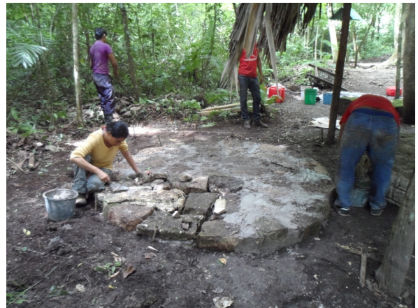
Figura 14.3. Proceso de construcción de la plataforma para el Altar 1. Foto Juan Carlos Pérez.
