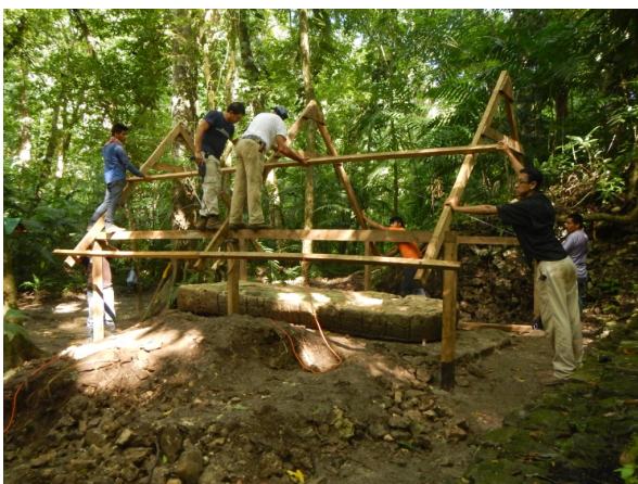
Figura 14.11. Colocación de costaneras para la armazón de la cubierta de la Estela 39. Foto Griselda Pérez.
