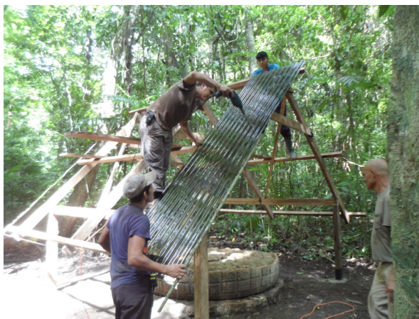
Figura 14.12. Atornillado de láminas de policarbonato en la cubierta del Altar 1. Foto Griselda Pérez.
