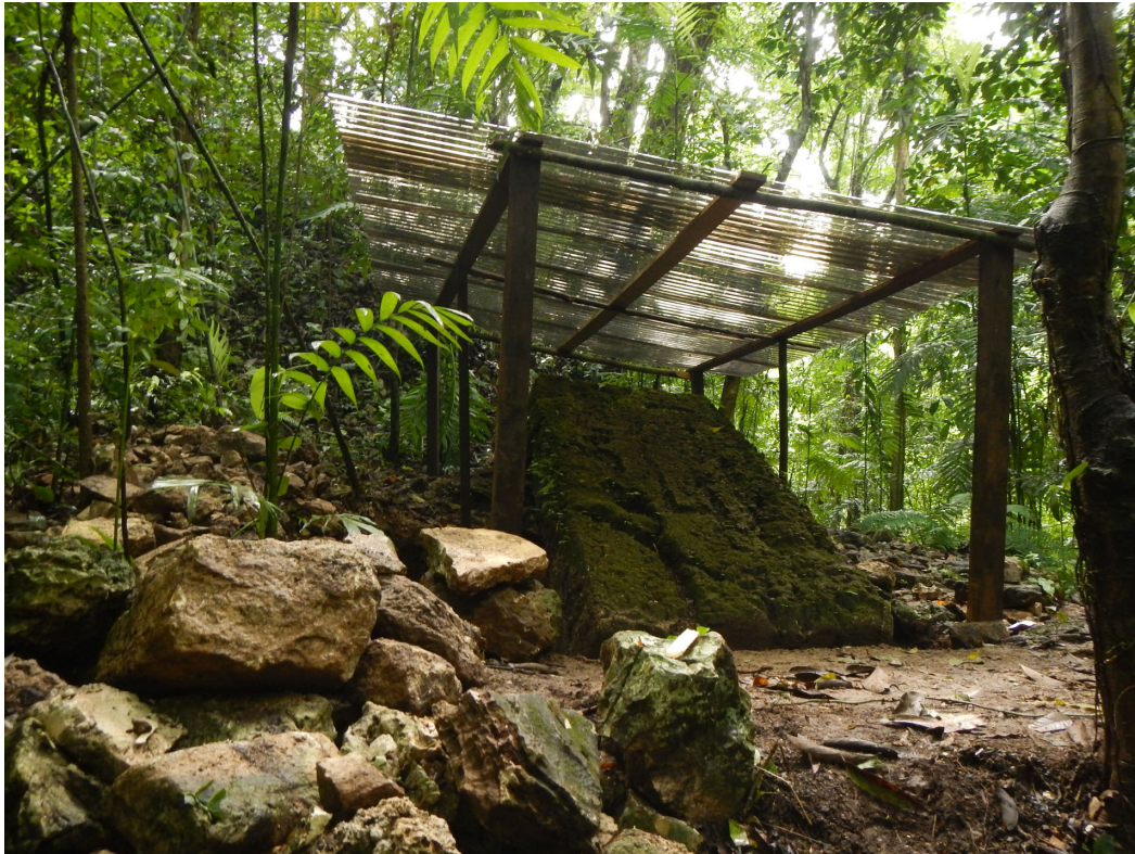
Foto 14.26. Estela 37 después de la intervención con su cubierta provisional. Foto Juan Carlos Pérez.
