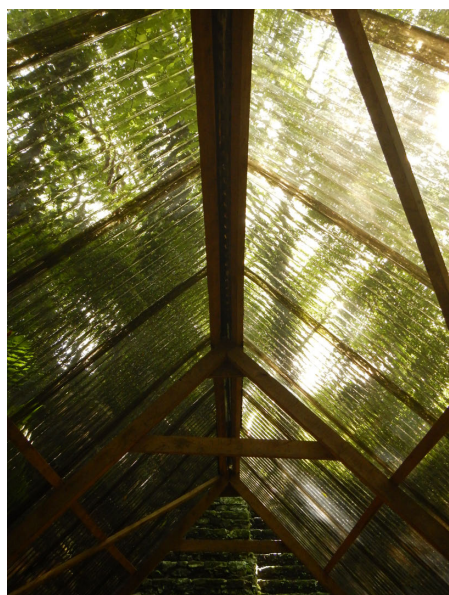
Figura 14.14. Detalle de la luz que ingresa a través de las cubiertas. Foto Juan Carlos Pérez.
