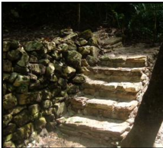
Fig. 17.44. Acceso 2 que conduce al Patio 1, acondicionado en el mismo lugar que el anterior, para continuar con el mismo circuito de visita.
