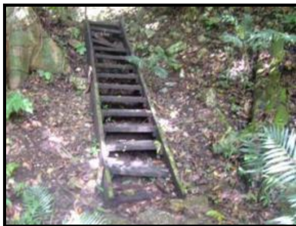
Fig.17. 43. Acceso 2 que conduce al patio 1 , la mayoría de los peldaños completamente deteriorados.
