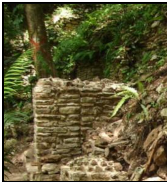
Fig. 17.38. Columna 3 y muro de separación después de la consolidación, rescate de su constitución estructural.
