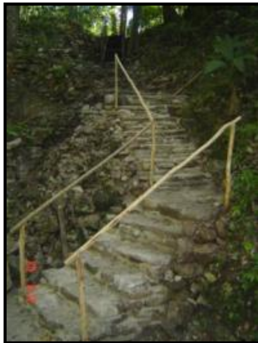
Fig. 17.46. Elaboración de la primera sección del Acceso 3 que conduce al Patio 2.
