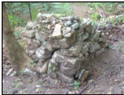
Fig. 17.33. Columna 2 previo a la intervención de consolidación.
