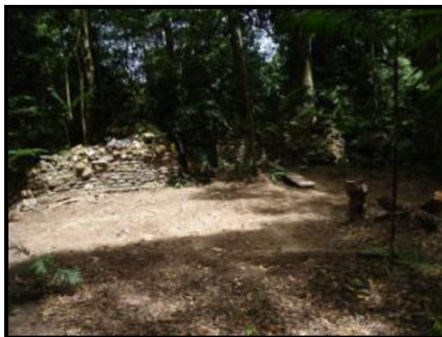
Fig.17.26. Situación actual del patio. Al fondo Edificio J-2, después de retirado el escombros.
