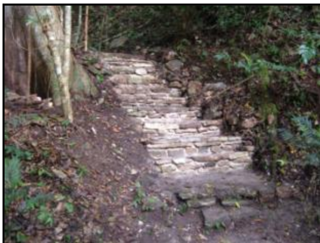
Fig. 17.42. Acceso 1 elaborado de piedra para sustituir el de madera, colocado junto a las escalinatas megalíticas.
