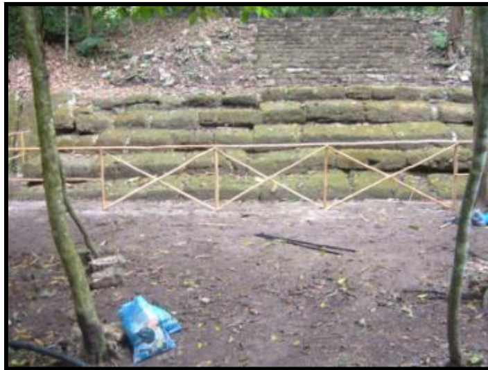
Fig.17.47. Colocación de los barandales de protección frente a las escalinatas megalíticas.
