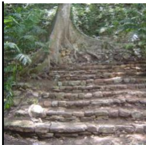
Fig. 17.24. Recuperación de la escalinata que conduce al Edificio J-6.
