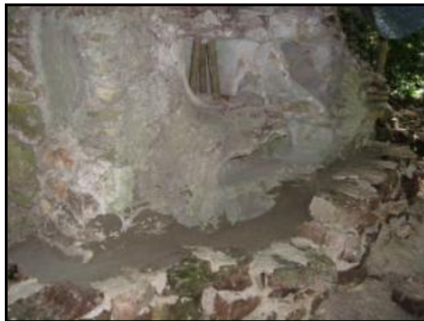
Fig. 17.30. Proceso de recubrimiento, colocación del muro de contención y relleno de arena de río.
