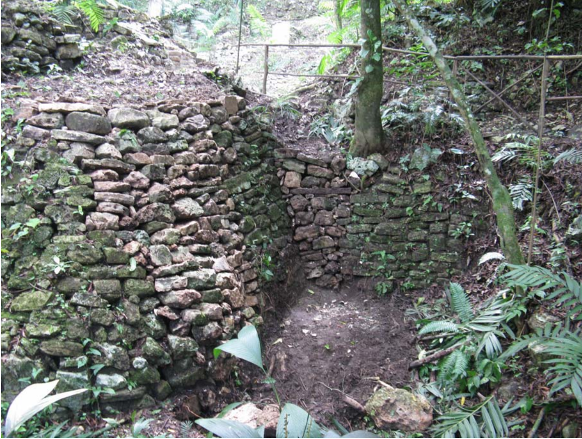
Figura 17.18. Aplicación de medidas preventivas de conservación en la esquina sureste de la plataforma del Palacio J-2.
