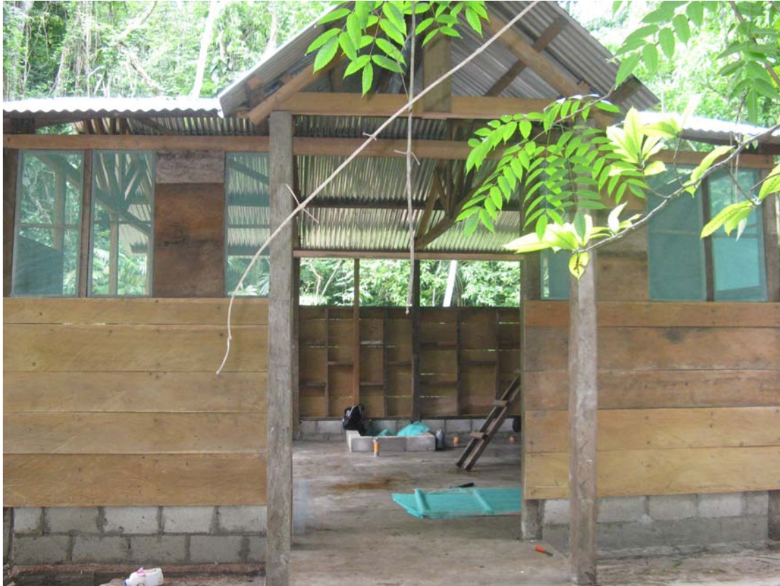
Figura 17.19. Vista final del Centro de Visitantes terminado.
