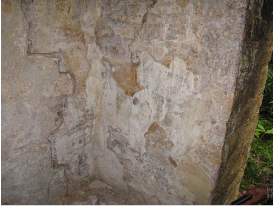
Figura 17.5. Daños internos del Palacio D3-1 del sitio arqueológico Teocolote.
