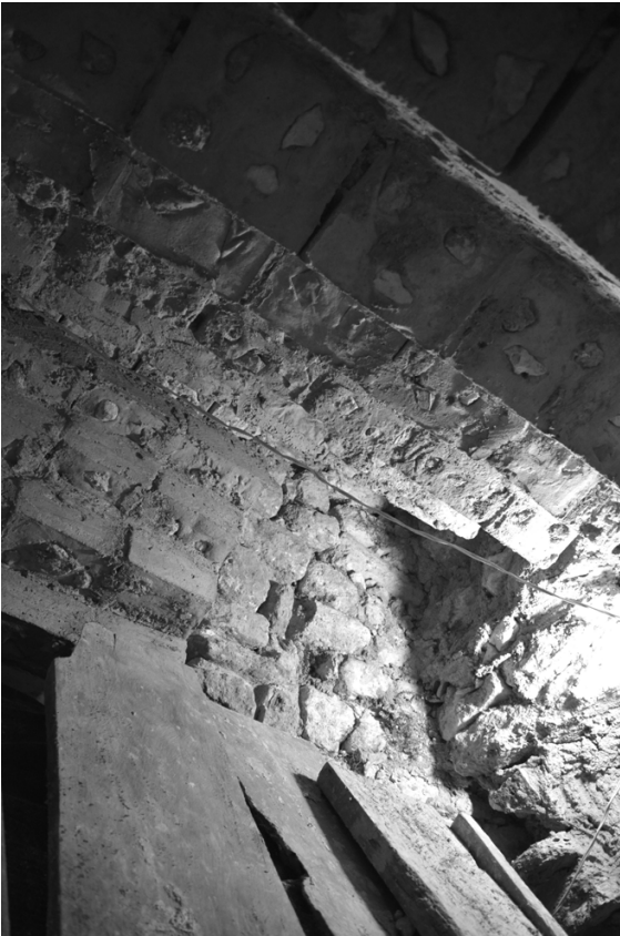
Fotos 1.21 (arriba izquierda) 1.22 (abajo izquierda) 1.23 (derecha) finalización de la estabilización exterior y estado actual de los trabajos finalizados en las inmediaciones de la Estela 44 Fotos: Juan Carlos Pérez 2016
