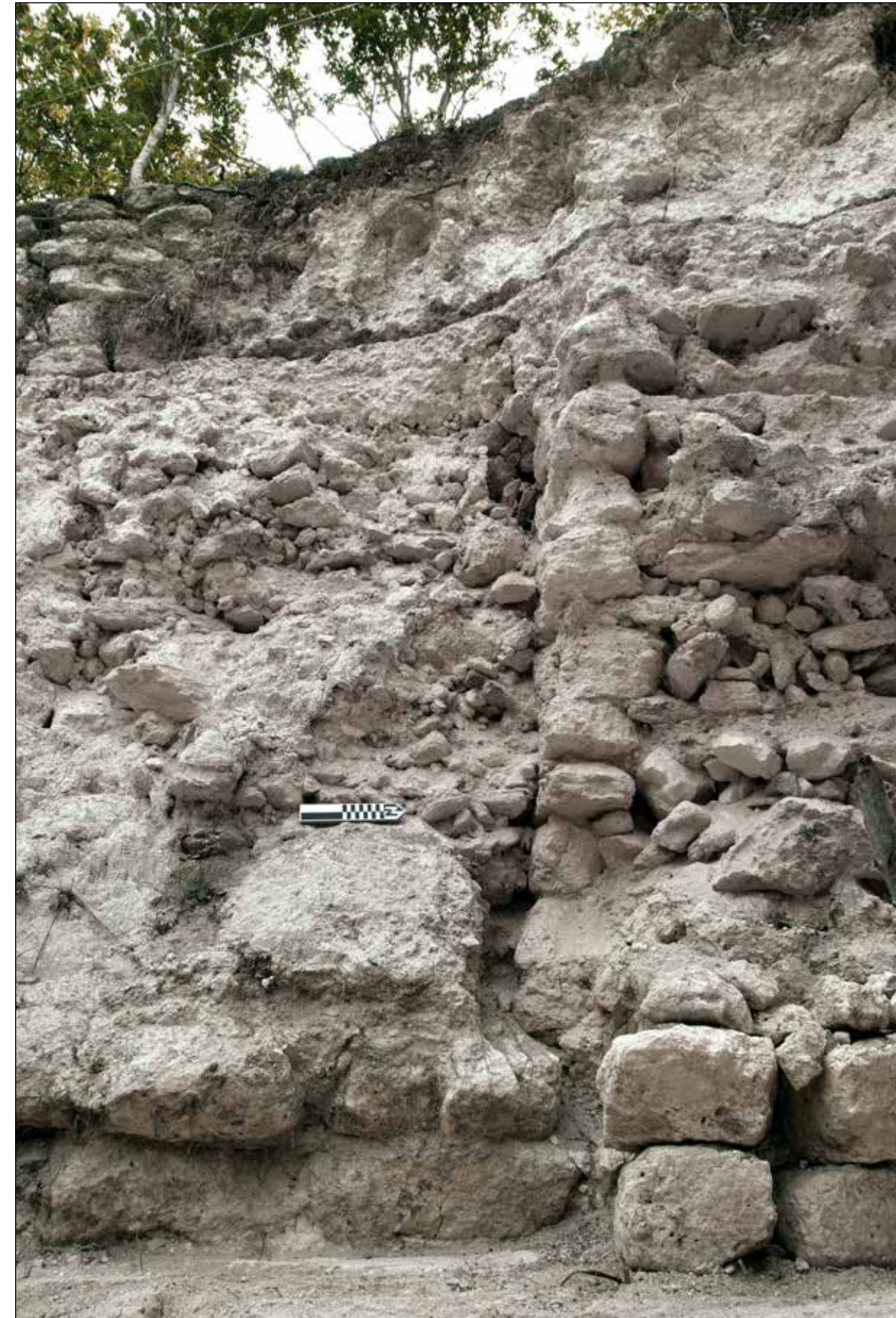
Figura 2.47. Relleno sobre el Templo del Sol Nocturno, con muros de retención construidos para evitar el desplazamiento lateral de la masa adicional colocada para construir la Estructura F8-1-2 a . Foto: Arturo Godoy.
