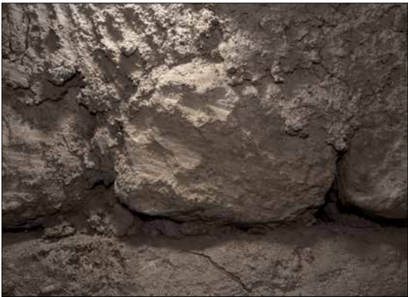
Figura 2.16. Marcas de rajuelas que dejaron los constructores en las piedras de la cámara. Foto: Arturo Godoy.
