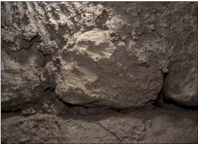
Figura 2.16. Marcas de rajuelas que dejaron los constructores en las piedras de la cámara. Foto: Arturo Godoy.
