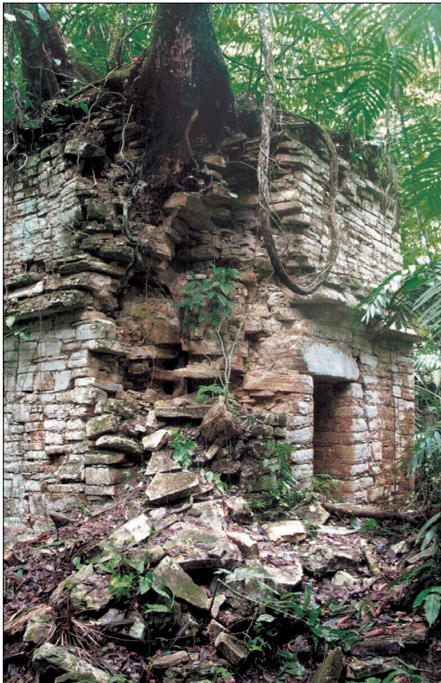
Figura 1. Edificio del Clásico tardío en Tecolote, sitio reubicado en el 2003 por el PRASL (foto de Charles Golden).
