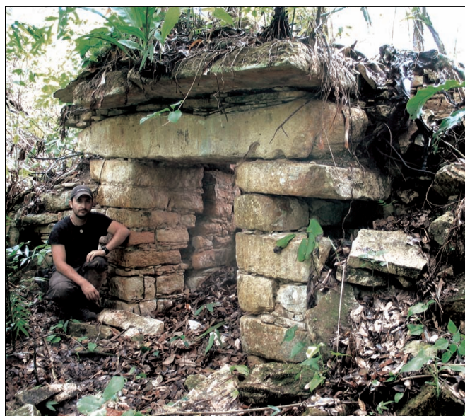
Figura 9. Puerta en el llamado Palacio de Las Puertas en el sitio de Oso Negro (foto de Charles Golden).
