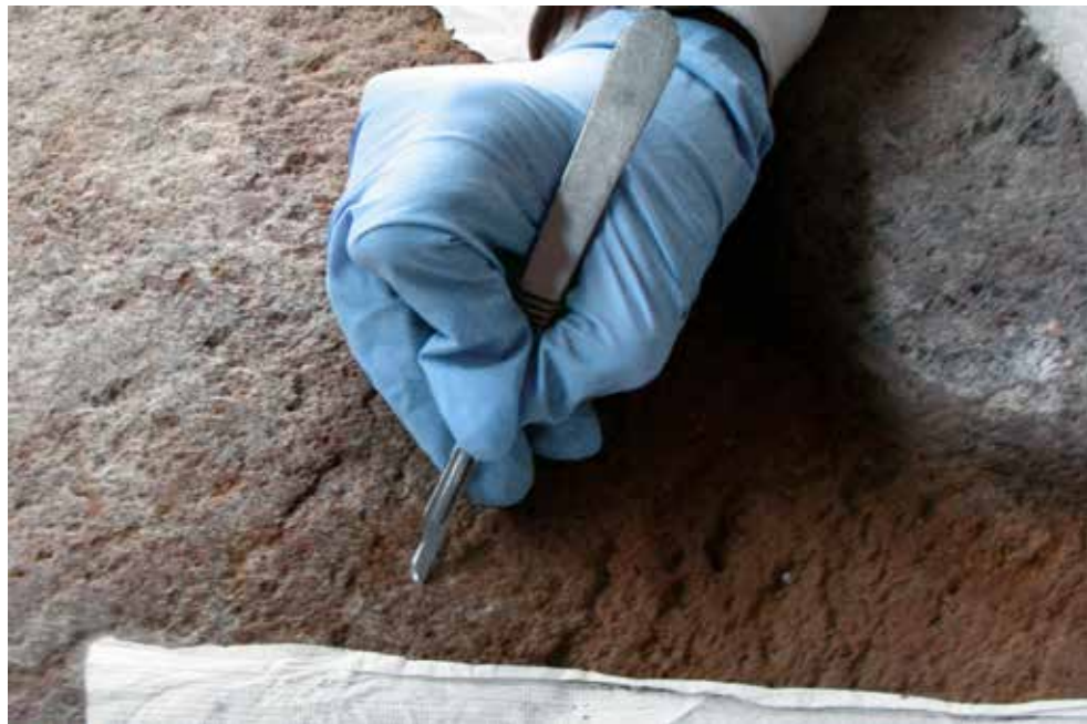
FIGURA 72. Eliminación de velos salinos con ayuda de bisturí (CBM).
