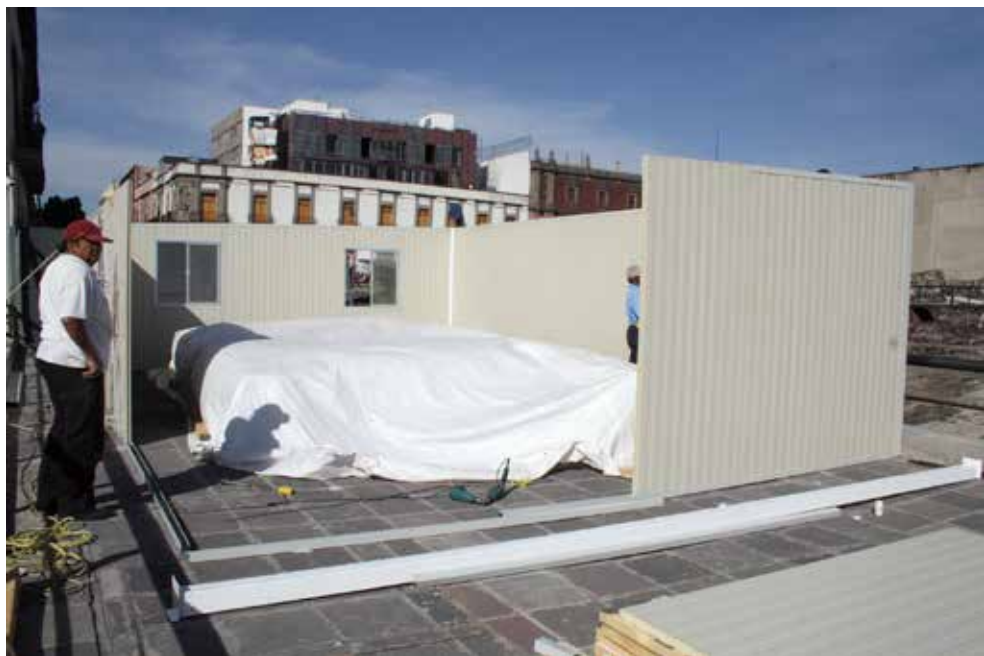
FIGURA 59. Construcción de la caseta de multipanel para resguardar los fragmentos (LLL).
