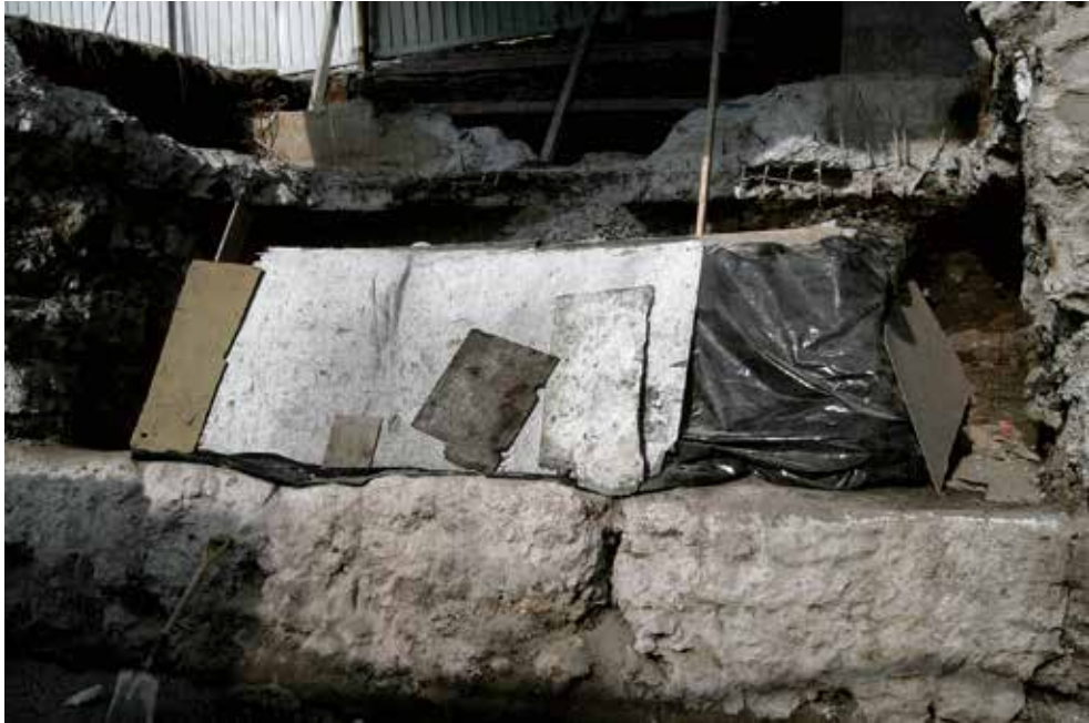
FIGURA 40. Coraza de protección utilizada durante los trabajos de retiro (VPC).
