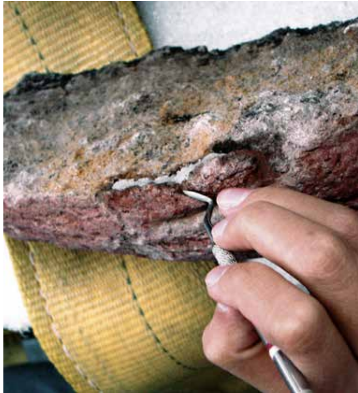
FIGURA 87. Aplicación de resanes (CML).
