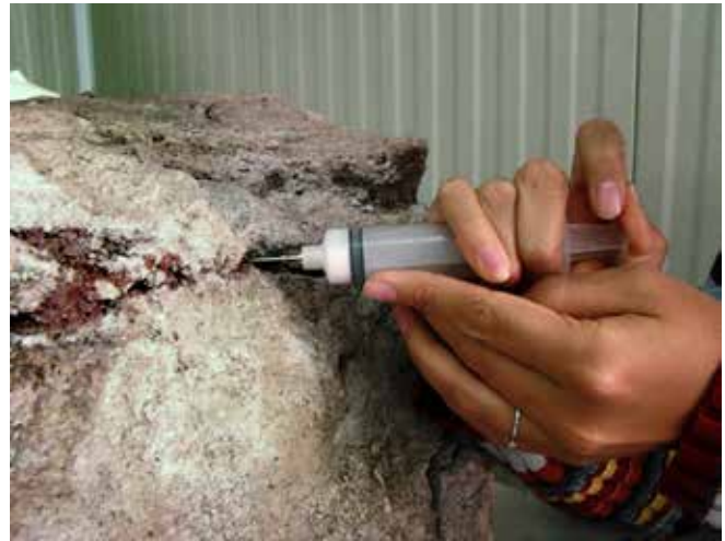
FIGURA 79. Inyección de consolidante + calhidra + tierra de diatomeas (CML).
