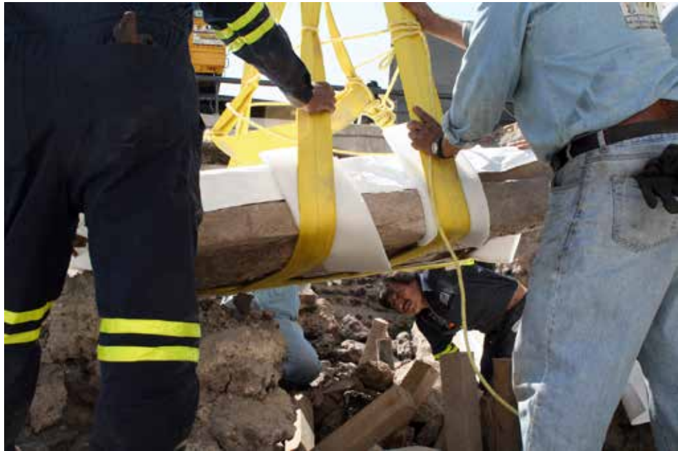
FIGURA 54. Revisión de los apoyos antes del levantamiento (JMG).
