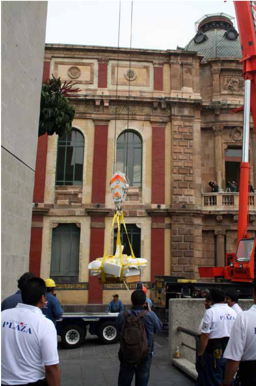
FIGURA 174. Manipulación de los fragmentos con la grúa de brazo largo (JMG).
