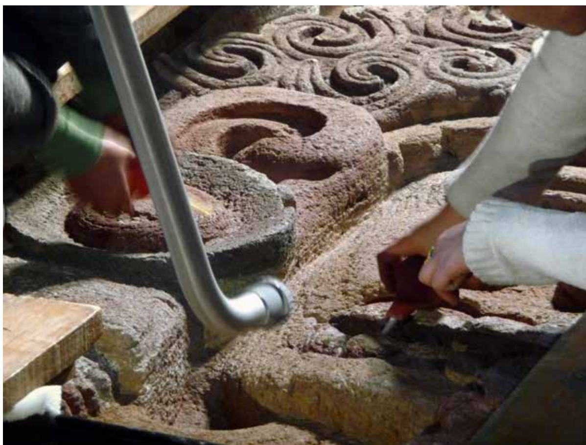
FIGURA 211. Retiro del polvo sobre la capa pictórica con brochas y perillas (MDA).
