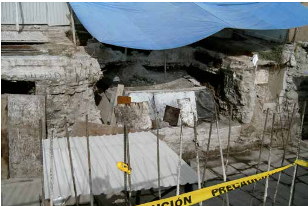
FIGURA 41. Vista general del relieve con su protección (VPC).
