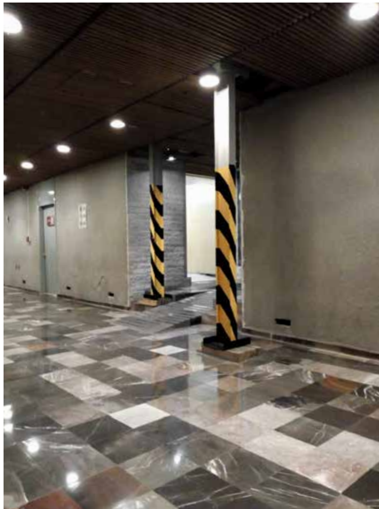
FIGURA 157. Puntales de acero instalados en el sótano del museo (MVC).
