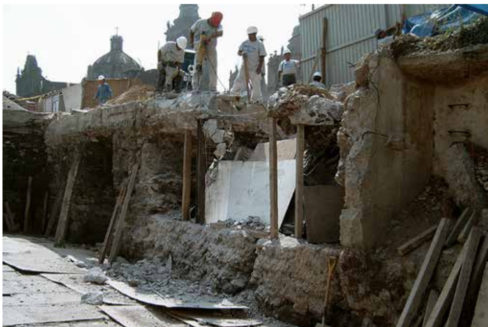
FIGURA 39. Retiro de losa de concreto con rotomartillo (vpc).
