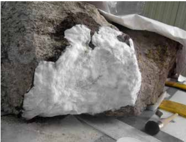
FIGURA 69. Aplicación de compresas con ácido acético al 5% (CBM).
