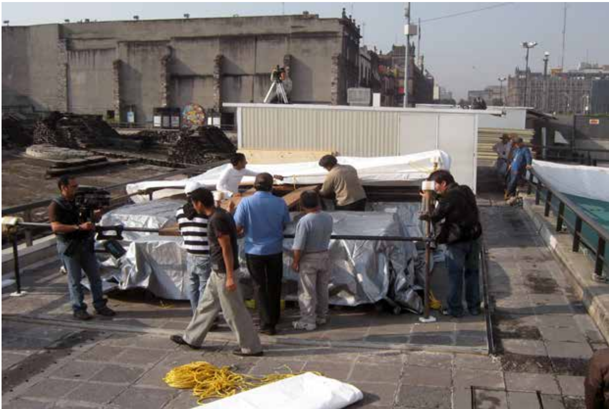
FIGURA 168. Desarmado de estructura tubular de protección (FCM).
