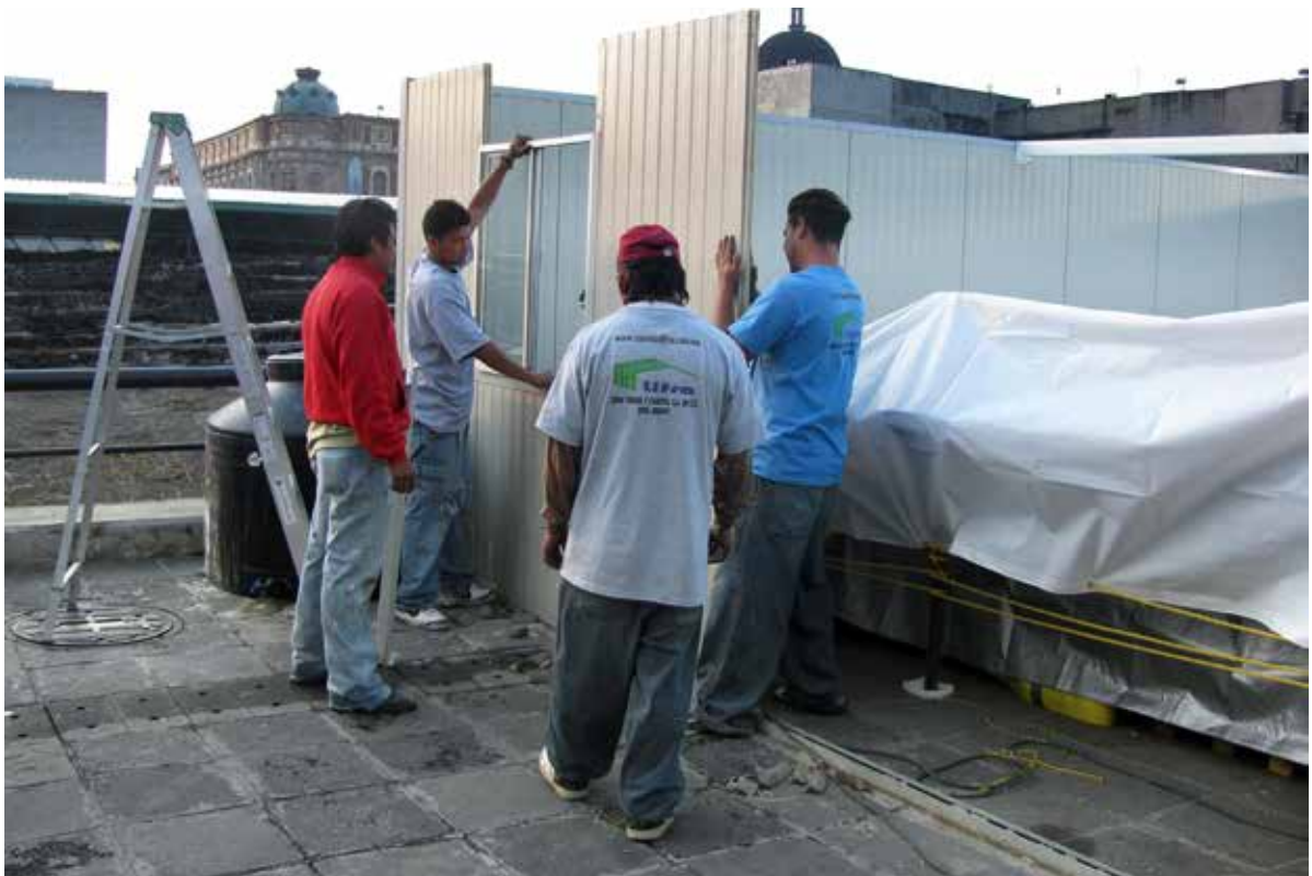
FIGURA 167. Proceso de desarmado de la caseta-laboratorio de multipanel (MVC).
