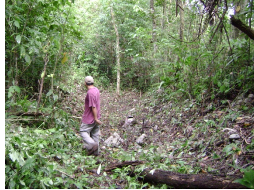
Foto 2. Despeje de material de derrumbe
