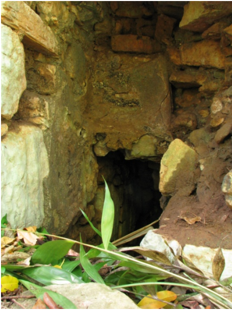
Fig. 14. Particular de la creación de un vano interior a través de la ampliación del edificio (foto Esteban Mirón)
