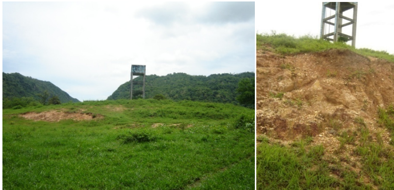
Imágenes de la elevación con la torre de agua.
