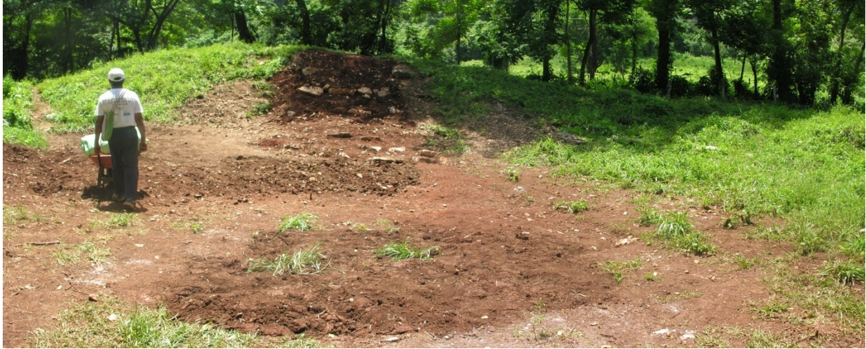
Fotografía de la excavación concluida y rellenada nuevamente.
