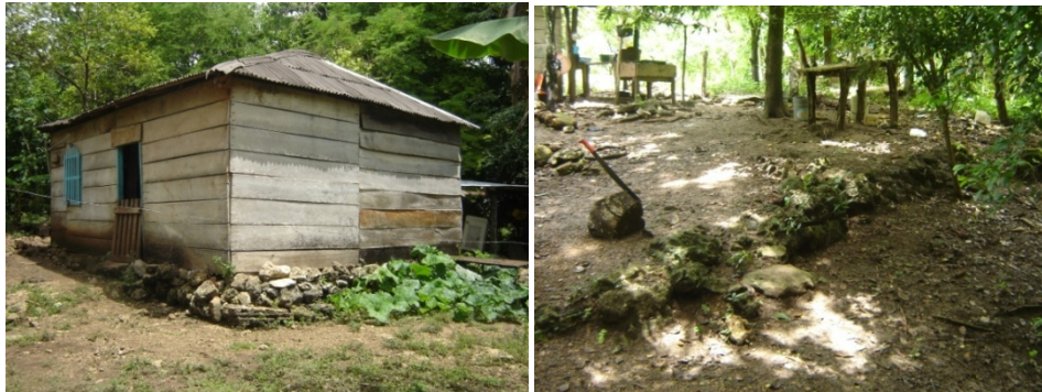
Imágenes del sitio con la reutilización de espacios habitables.
