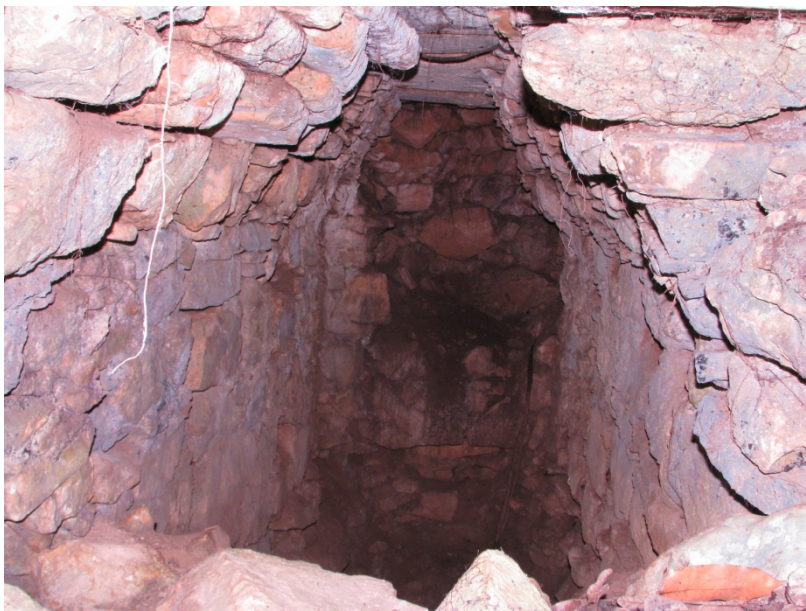
Fig. 16. Bóveda superior del “edificio Maler” (foto Esteban Mirón)
