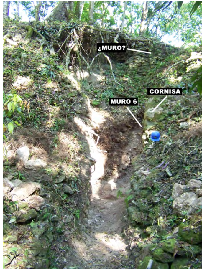
Figura 2.1.32. Rasgos constructivos expuestos por saqueo (Fotografía: L. Velásquez, 2014).
