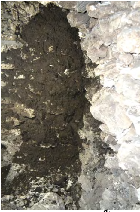
Figura 4.1.23. a) Consolidación de la unidad 11. Utilizando muros de contención de piedra caliza con mezcla de lodo; b) Proceso de consolidación interior Sub-1. (Fotografía: D. Del Cid, 2014).
