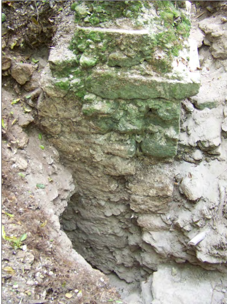
Figura 2.1.36. Exposición de la fachada norte del Muro 6, Operación XUL 111K15-A-4 (Fotografía: L. Velásquez, 2014).
