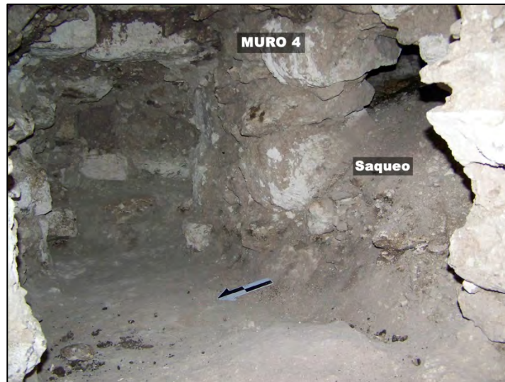
Figura 2.1.17. Saqueo al final de la ramificación este que rompió el Muro 4 (Fotografía: L. Velásquez, 2014).
