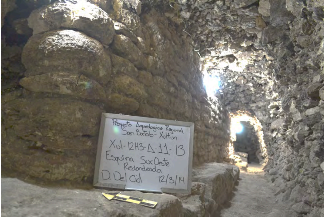
Figura 4.1.7. Unidad 11, Xul 12H3-Sub-2-A-11. Esquina redondeada suroeste de Sub-2 y detalle de banquetta. (Fotografía: D. Del Cid, 2014)
