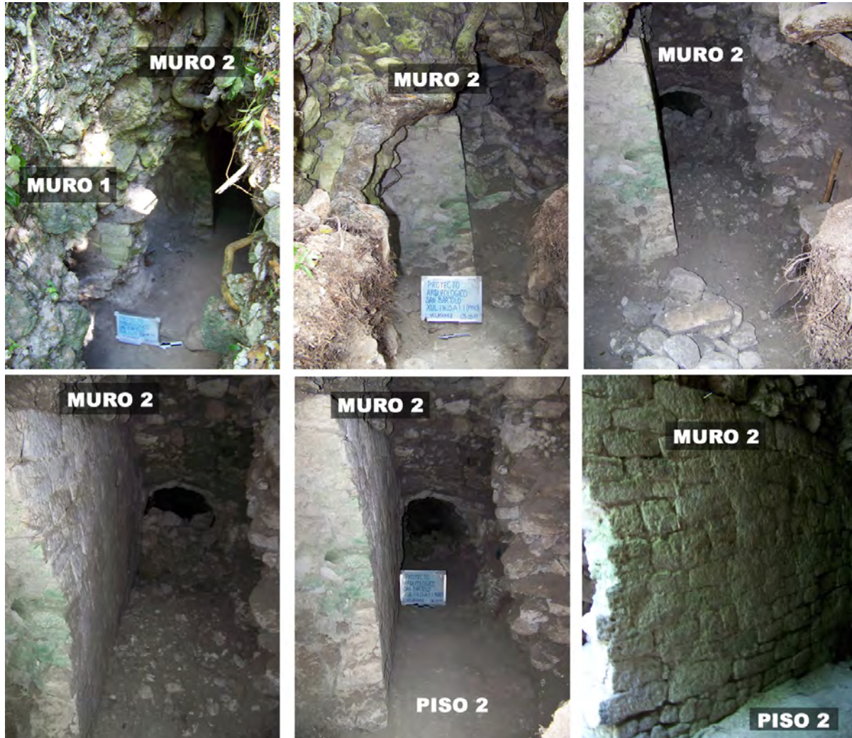
Figura 2.1.13. Proceso de limpieza de la Operación XUL 11K15-A-1 y la identificación de los rasgos constructivos, Muro 2 y Piso 2 (Fotografía: L. Velásquez, 2014).
