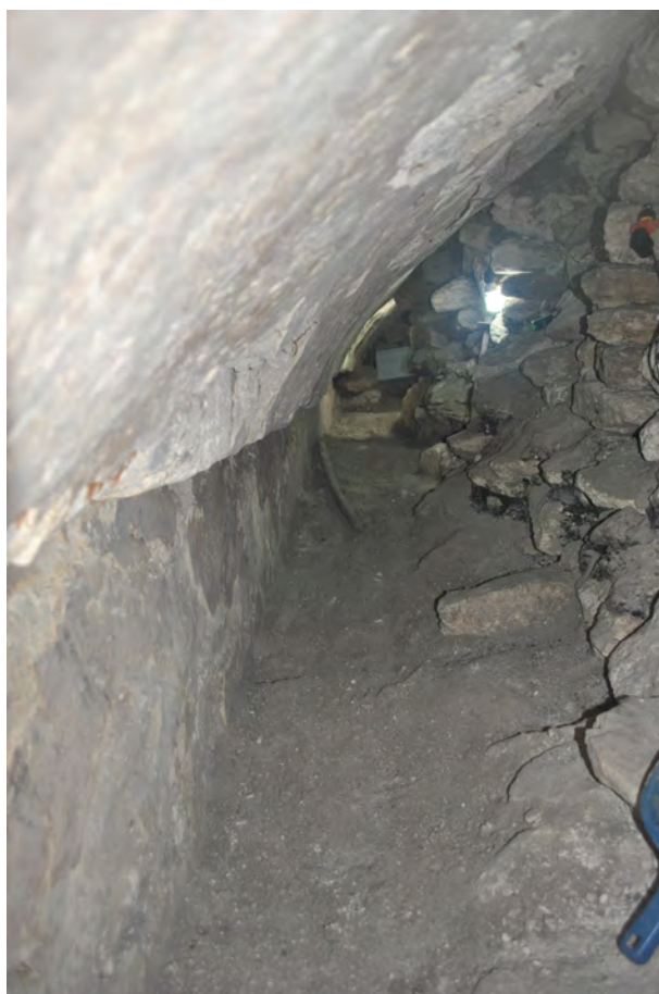
Figura 3.2.12. Vista de las excavaciones en XUL 12F19-A-20 desde el lote 2, hasta el final del lote 7. (Fotografía: P. Medina, 2014)
