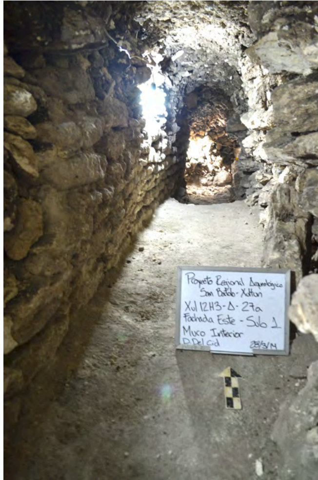
Figura 4.1.3. Fachada este de Sub-1, al fondo se observa el desnivel del piso cortado. (Fotografía: D. Del Cid, 2014)
