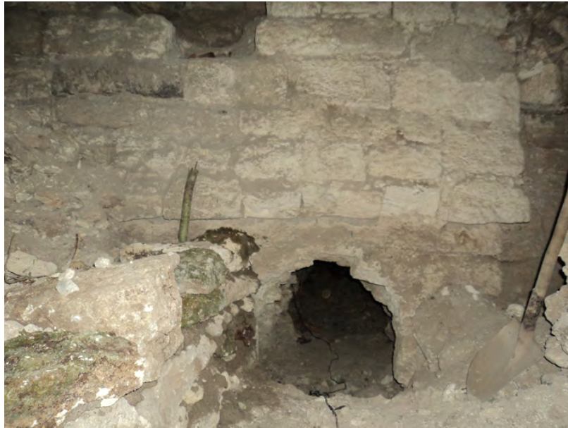
Figura 2.2.59. Extensión del saqueo oeste, en donde se muestra la destrucción de una sub fase arquitectónica. (Fotografía: R. López, 2014)
