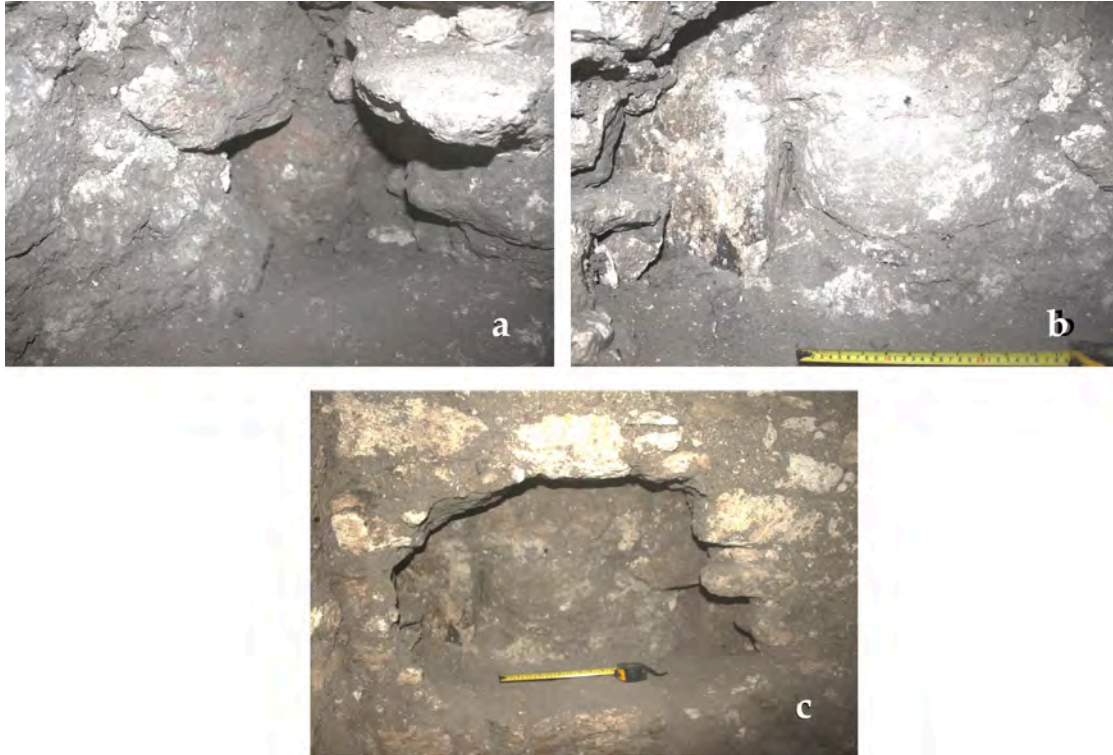
Figura 3.2.33. Puerta en el lado posterior del Edificio Ramón, XUL 12F19-A-21-9. A) Jamba este, erosionada; b) Jamba oeste con estuco pintado color negro; c). Registro para determinar si era un muro o un acceso, el metro apunta hacia el oeste (Fotografías: E. Mencos, 2014)
