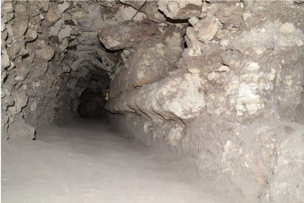
Figura 4.1.20. Fachada oeste de Sub-3, Túnel A-18, vista de sur a norte, detalle de cornisa en muro. (Fotografía: D. Del Cid, 2014).
