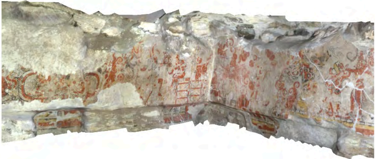
Fig. 8.1.20. Vista del estado de conservación de los muros oeste y norte. (Fotografía M. Stefani, 2014).
