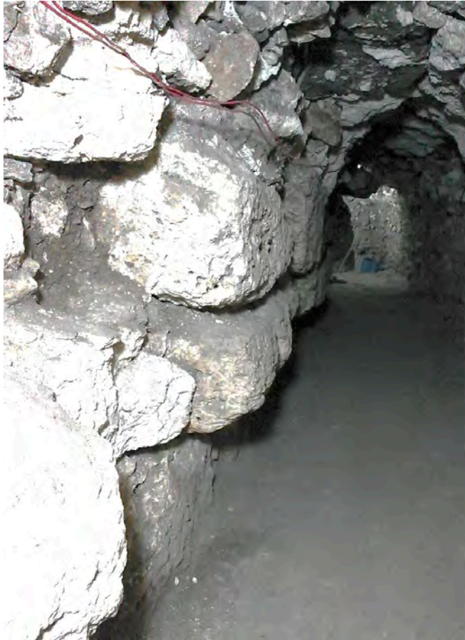
Figura 4.1.12. Cornisa y proyección con el alineamiento de los bloques medios y superiores. (Fotografía: H. Pérez , 2014)
