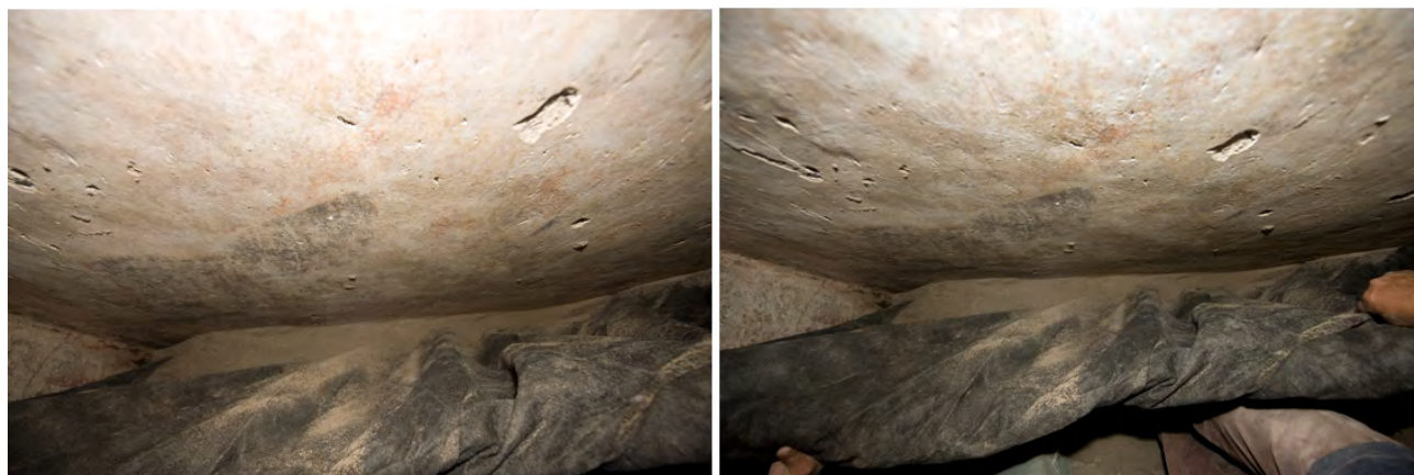
Figura 7.1.8. Detalle de protección de los murales con tierra cernida y geotextil, Estructura 10K2, Xultun. (Fotografía: B. Beltrán, 2014)
