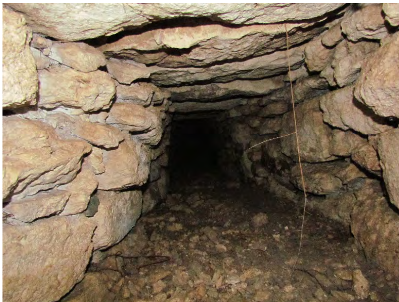
Figura 1.2.18. Vista norte en canal abierto (Fotografía: J. Ruane, 2014).
