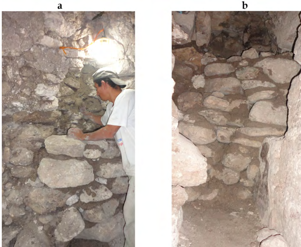
Figura 2.2.56. Relleno y consolidación de la trinchera de saqueo este, Estructura 11K12 (Fotografías: P. Rivera Castillo, 2014).
