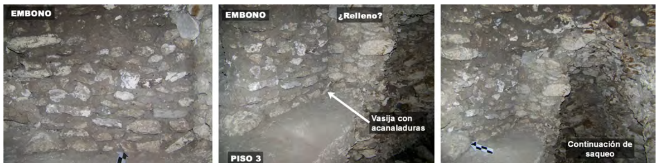
Figura 2.1.25. Muro 5 expuesto y mezclón que limita con el corte del muro (Fotografía: L. Velásquez, 2014).
