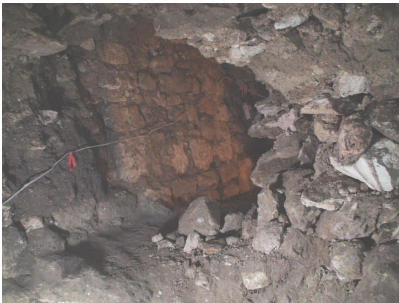
Foto 1.6. Detalle del escombro de colapso de la Unidad 117, en la entrada de la cámara funeraria del Entierro 61. Al fondo el muro oeste del Templo de M13-1 Sub II. Foto Griselda Pérez
