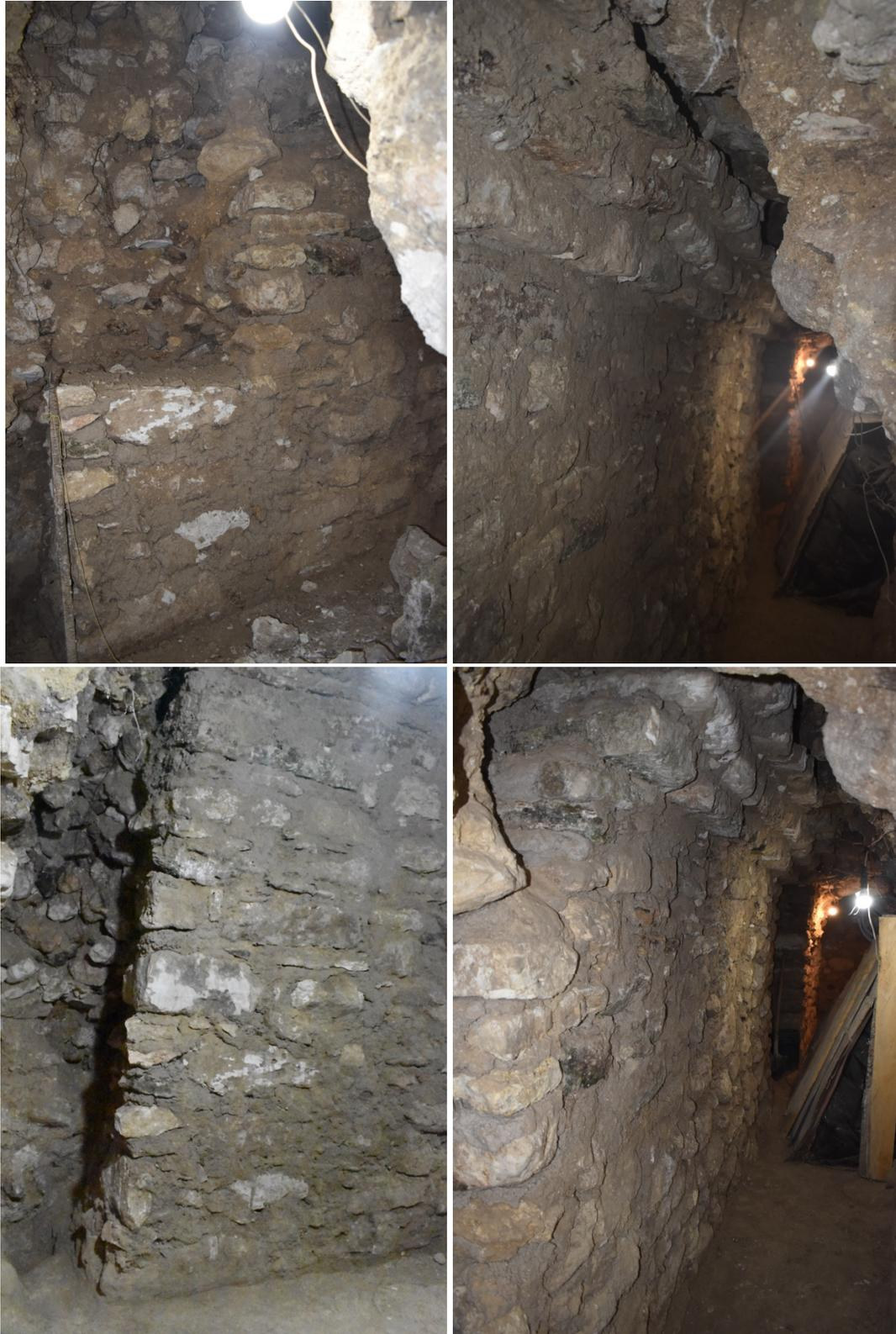
Figura 1.1. 8. Proceso de consolidación de muros para estabilizar túnel N/S de Sub II, (fotografía Del Cid 2024).
