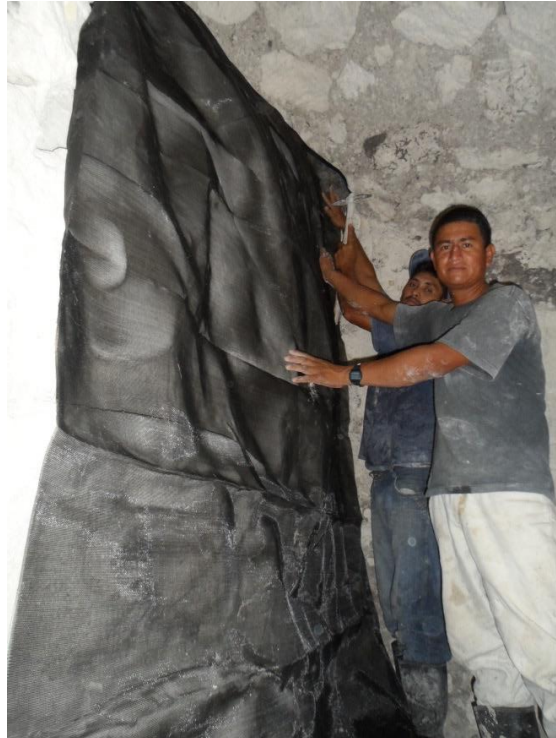
Figura 6.15. Detalle del recubrimiento con geotextil antes del re-enterramiento del mascarón (Fotografía por Edwin Pérez Robles).
