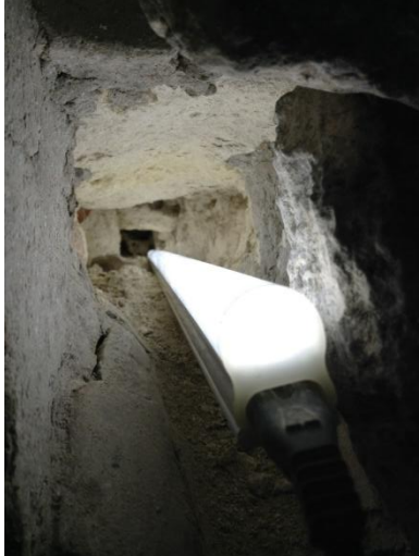
Figura 8.4. Luz LED de un metro de largo, ingresada dentro, en donde se ve la profundidad y forma convexa del ducto, el cual estaba cubierto en la parte superior por piedras que forman parte de la edificación; la luz fue ingresada en los dos ductos sin poder llegar al tope del mismo (Foto E. Pérez 2018).
