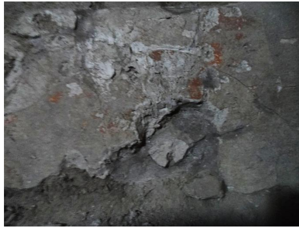
Figura 8.45. Área en tratamiento, nótese la distinta tonalidad del estuco nuevo en fisuras y grietas tratadas. La proporción para resane fue 2:1 en las que consolidaron fisuras y grietas, y los resanes de sacrificio fueron en proporción 3:1. (Foto: E. Pérez, 2018).
