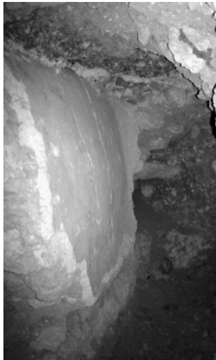
Figura 9.11. Detalle de rellenos y subestructura impactado por actividades ilícitas en grupo identificado en Cuadrante Q-9. (Fotografía: Rafael Cambranes, 2018).
