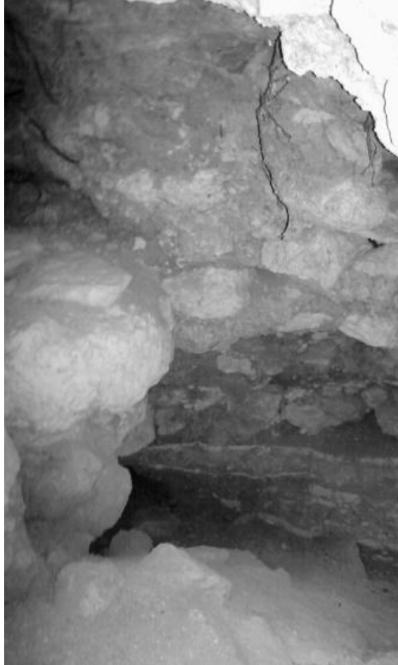
Figura 9.14. Registro de saqueos. Detalle de rellenos expuestos y rasgos arquitectónicos por actividades ilícitas en grupo identificado en Cuadrante I-5, sector oeste de El Palmar. (Fotografía: Rafael Cambranes, 2018).
