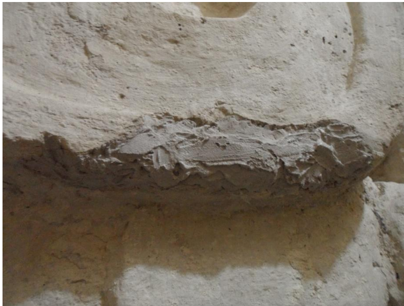
Figura 8.48. Aquí se muestra el proceso de resane, en el área afectada, el procedimiento de consolidación mediante la aplicación de estuco en proporción 3:1. Mascarón Norte, fachada Oeste (Foto: E. Pérez, 2018).
