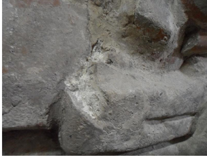
Figura 8.42. Fotografía que expone la piedra de soporte del estuco, antes de ser resanado. La capa de estuco aplicada, fue en proporciones 2:1 cal y arena tamizada. La arena es extraída de las mismas excavaciones que tienen la misma tonalidad grisácea del estuco original. (Foto: Edwin Pérez, 2018).
