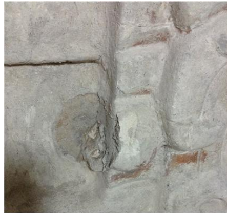
Figura 8.37. Fragmento del muro oeste, en donde se observa la forma de construcción por medio de aditamento en donde modelaban para después adherirlos al muro.(Foto: Edwin Pérez, 2018).
