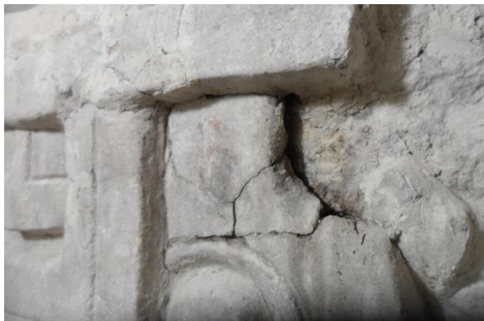
Figura 8.30. Fotografía que muestra el daño efectuado por una raíz en un lateral del friso lado oeste; se retiró la raíz y limpió el área con brochas de cerdas finas, posteriormente se removió el fragmento
