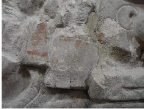
Figura 8.39. En esta fotografía se pueden apreciar fisuras en una parte del friso, bajo el mascarón derecho del muro oeste, estas fisuras provocaron debilitamiento en el área. En el tratamiento se eliminó el resane anterior y se retiró el fragmento marcado, se limpió mecánicamente con brochas, luego se humedecieron el fragmento y el área hasta punto de saturación, una vez el área estuvo preparada se le aplicó una capa fina de estuco cal y arena 1:1, y se fijó nuevamente en su lugar, para mantener la presión y ayudar en el fraguado de las partes adheridas. Se sostuvo con dos varitas de apoyo. (Ver fotografía inferior).(Foto: Edwin Pérez, 2018).
