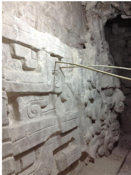
Figura 8.32. Cuando el fragmento ya se encuentra adherido en su lugar, es necesario inmovilizar y sostener el mismo, con la ayuda de dos varitas de madera (aprovechando los recursos al alcance) con las puntas redondeadas, se fijan en un extremo al túnel y el otro sosteniendo el fragmento, así la pieza se mantiene en su lugar, con una presión constante mientras el proceso de fraguado lo termina de adherir. (Foto: Edwin Pérez, 2018).
