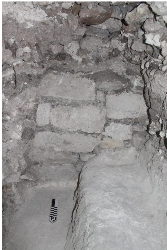
Figura 7.8. Foto del muro de contención que se encontró en el final de EP-10A-15-1 (foto por T. Garrison, 2018).
