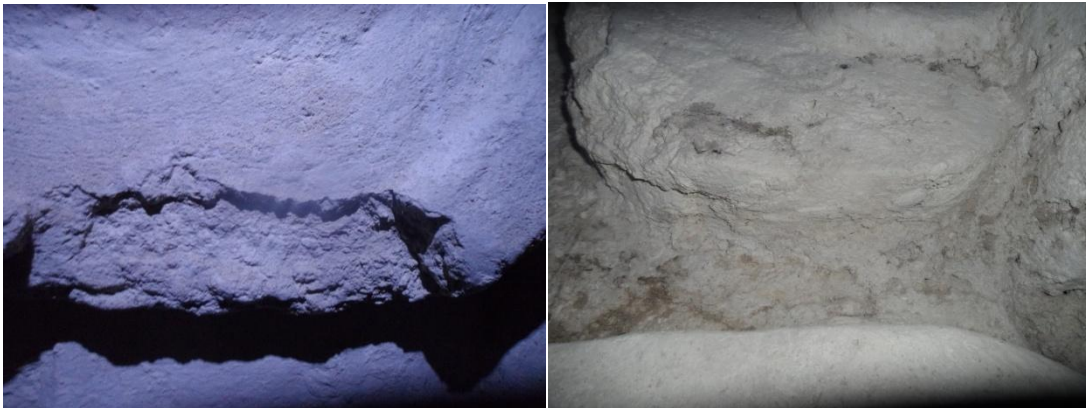
Figuras 8.20 y 8.21. Áreas de tratamiento de uno de los mascarones del Edificio M7-1 ubicado en el sitio El Zotz, se consolidaron bordes y fisuras y las áreas en donde existe pulverulencia fue asperjada para proceder a la aplicación de resane de sacrificio (Fotos, E. Pérez 2018).
