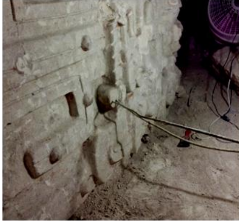
Figura 8.36. Fragmento que presentaba fragilidad y pérdida de adhesión, se retiró completamente y limpió, para recolocar se le aplicó estuco al 2:1, se saturó en agua de cal y finalmente se adhirió al soporte. También fue necesario utilizar las varitas como herramientas de apoyo.(Foto: Edwin Pérez, 2018).
