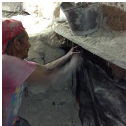
Figura 8.5. Don Humberto Amador (QEPD) en el proceso de excavación y revisión del estado de conservación del muro y del geotextil colocado en el año 2014 (Foto E. Pérez 2018).
