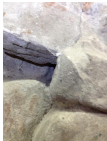
Figuras 8.14 y 8.15. Fragmento con pérdida de adhesión, al ser retirado, muestra dos incisiones de anclaje en donde la pieza fue adherida por los mayas al momento de su construcción (Fotos, E. Pérez 2018)
