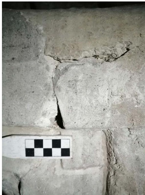
Figura 5.10. fracturas expuestas en donde hay pérdida de resanes, los cuales se separaron después del impacto y fueron removidos los restos para colocar nuevos resanes (E. Pérez, 2021).
