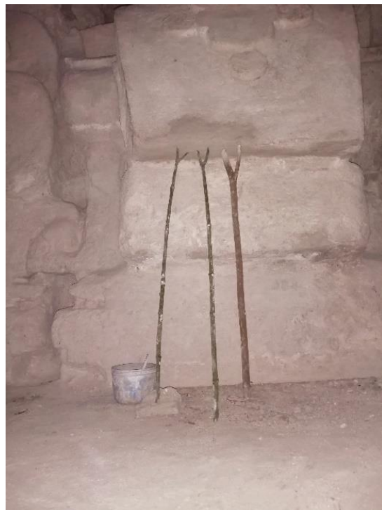
Figura 5.14. Área con resane estético ya efectuado, es necesario humedecer todos los días para evitar la resequeidad en el resane (E. Pérez, 2021).
