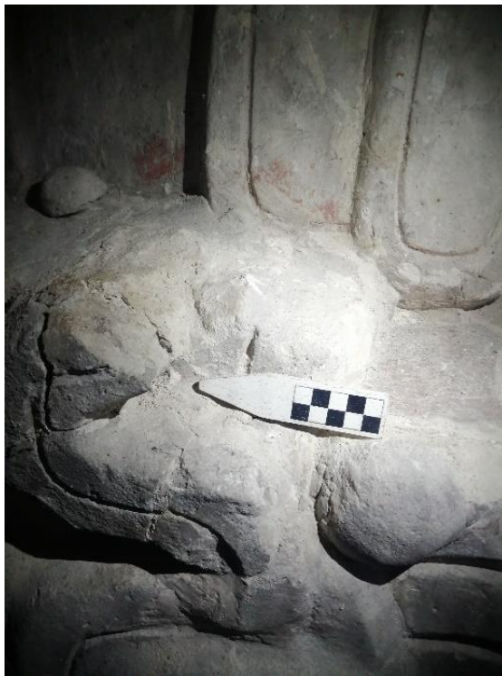
Figura 5.8. Área de impacto de piedra en la parte superior del mascarón en donde se observa parte de las fracturas y disgregación de material provocado por el impacto de las piedras (E. Pérez, 2021).
